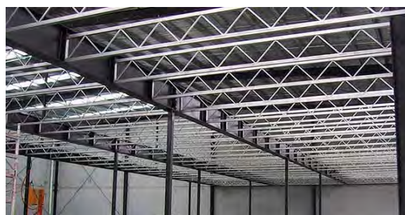
شکل ۱- سیستم سقف تیرچه با جان باز (Open Web Joist)
